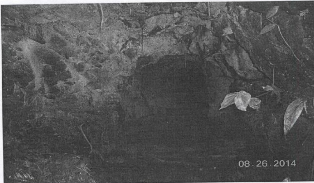
Foto.2. Entrada a la boca mina uno antes de la quebrada de las iglesias se evidencia la Restauración progresiva por el camino que conduce al área.
