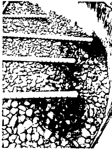
Foto 7. Filtro percolador con material de río
