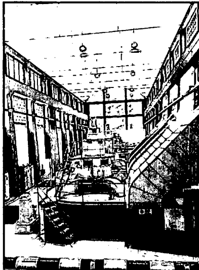
Foto 5. Turbinas Casa de Máquinas Bajo Anchicayá
