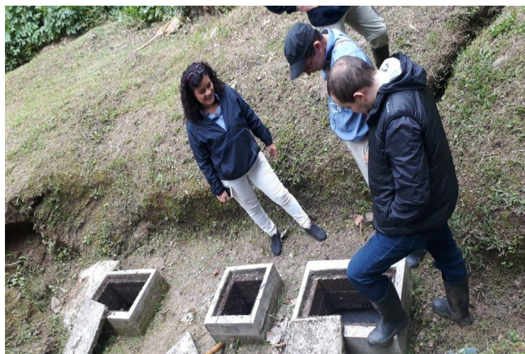
Foto 2. Tanque Séptico
