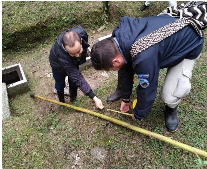
Foto 1. Inspección pozo séptico
