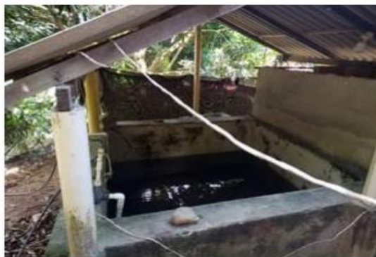
Figura 18 B, cambio de techo baño
