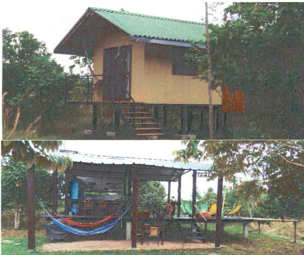
Figura 12. Zona de Uso Intensivo e Infraestructura de la RNSC "YURUPARÍ". Fuente visita técnica PNNC 8-10 marzo de 2021.
