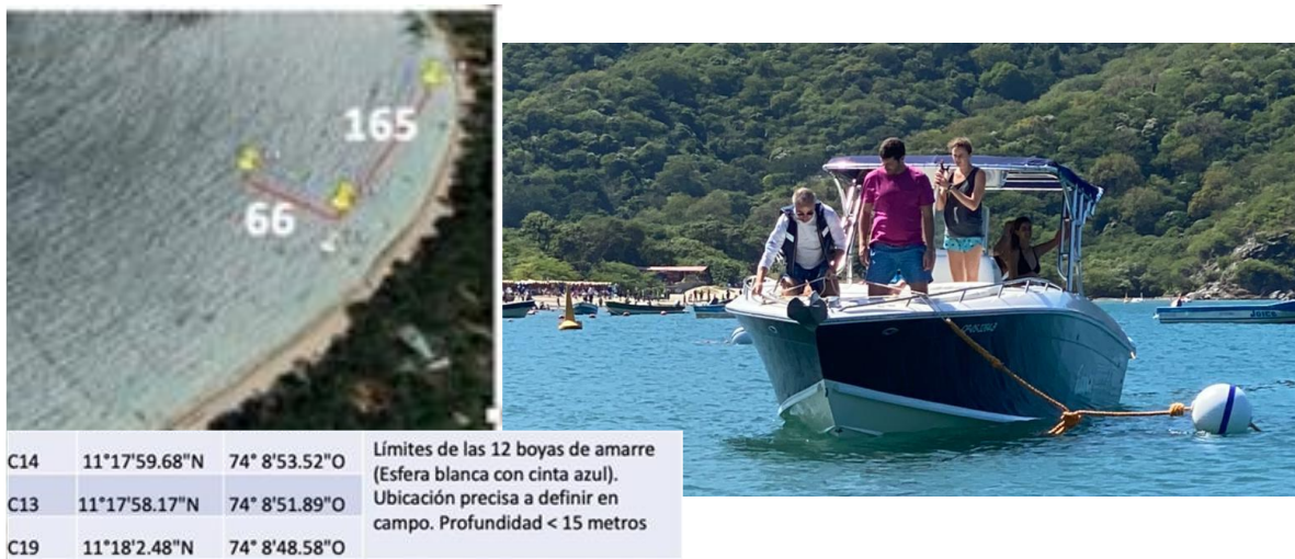
Figura 51. Sistema de amarre de embarcaciones instalado en la zona Norte de la Playa Principal de Bahía Concha – PNNT.
