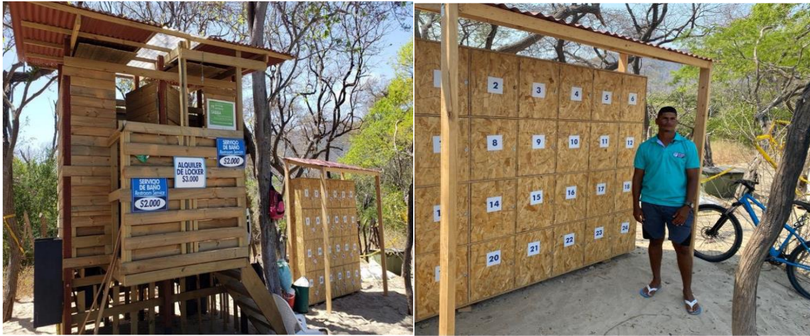
Figura 21. Vista General de Baños Secos y Lockers en el Sector de Bahía Concha - PNNT
